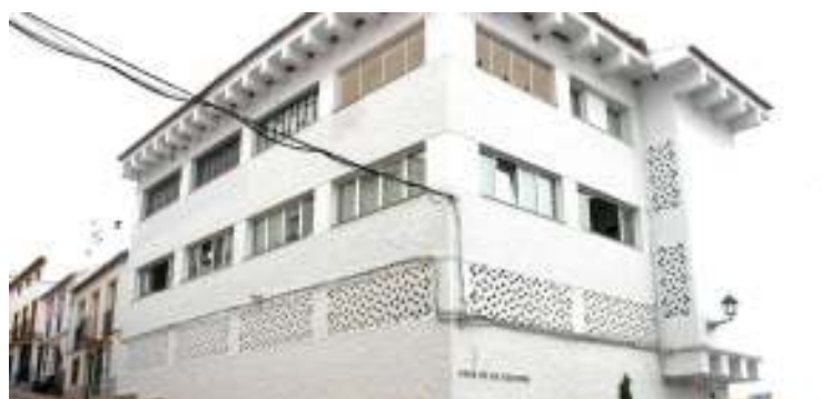
✚ Fachadas sur y este de la Casa de la Cultura de Olvera, que presentaban movimientos.
