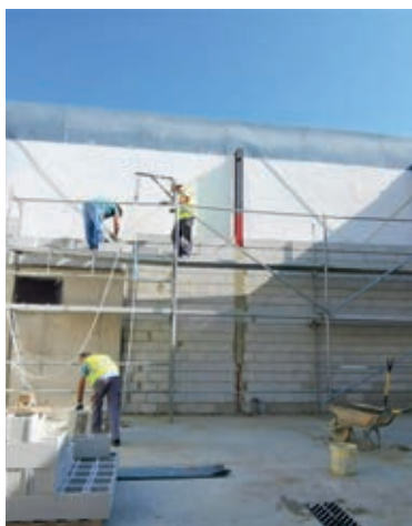
Ampliación nave para uso como vivero de empresas en el nuevo Polígono Industrial.
