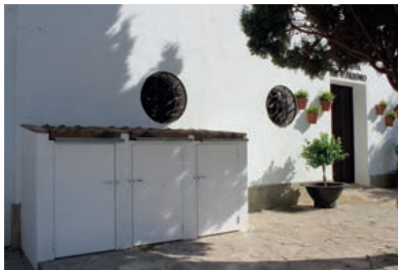
El resultado de las obras en la Plaza de la Iglesia.
