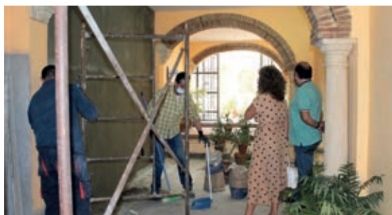
Obra de mejora y embellecimiento del acceso al castillo.
