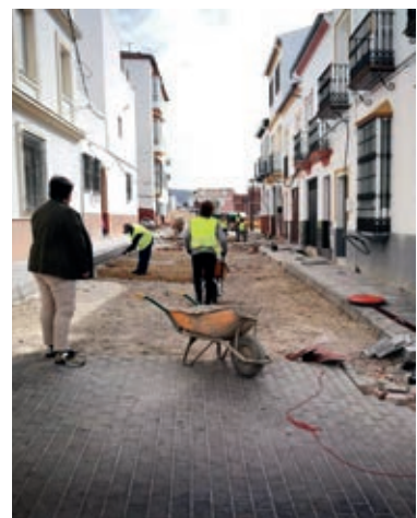
La calle Grazalema durante el desarrollo de las obras.
