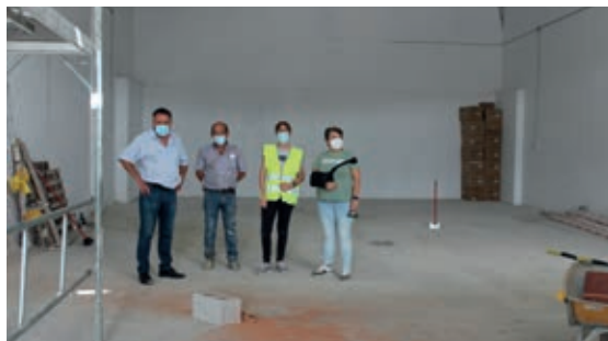
Una nueva nave para vivero de empresa y uso comercial se está construyendo en el Polígono.
