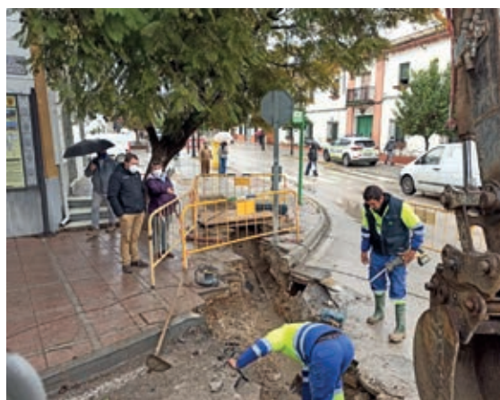
Obras de mejora en la red de abastecimiento de agua en calle Subida a la Iglesia y en Plaza de la Concordia.
