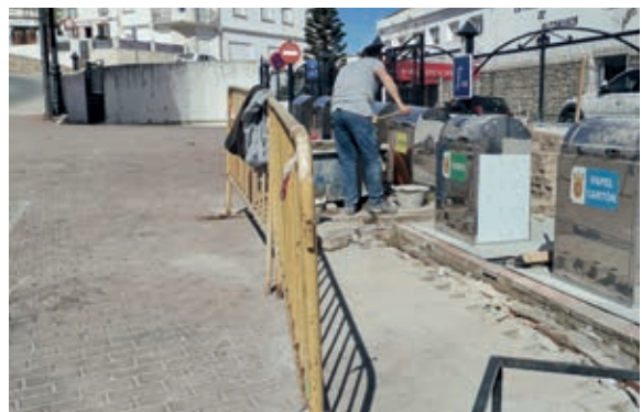
Contenedores soterrados ubicados en la Estación de Autobuses.
