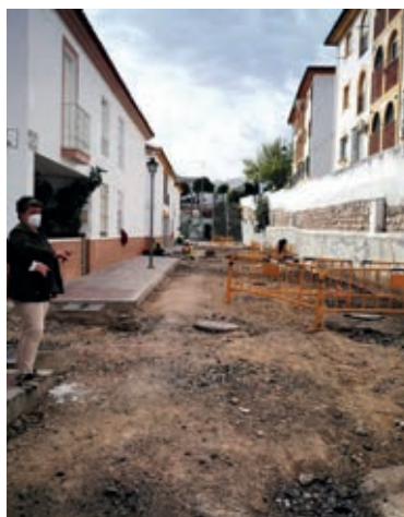
La concejala-delegada de Obras, M.ª Carmen Bermúdez, visitó las obras en Urbanización San Carlos.
