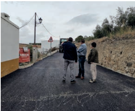
En la calle Pañolillas se ha instalado una nueva red de suministro de agua y sustituido la capa de asfalto.
