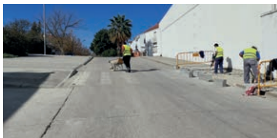
Rebaje del paso de peatones de la Vereda de Pino, que da acceso al Polígono Industrial.
