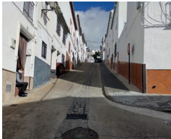
Nueva acera en el tramo de la calle Salada, que va desde Plaza del Socorro hasta la confluencia con calle Socorro.
