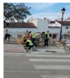
En la avenida Manuel de Falla se creó un saliente para mayor visibilidad en el paso de peatones.
