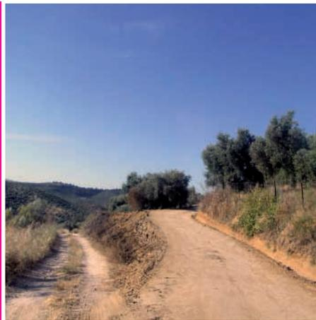
**Camino de las Cruces:** En el camino de las Cruces, con una longitud de 635 metros lineales y 3 metros de anchura, se ha realizado la construcción de un badén de hormigón de 25 centímetros de espesor y se ha trabajado en la construcción del firme de todo el camino.
