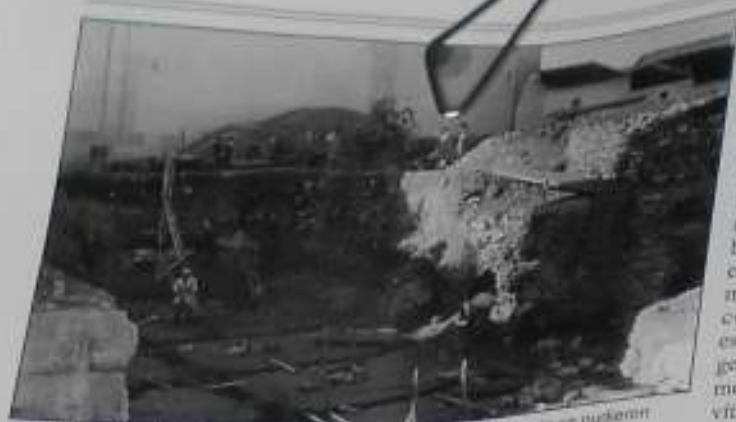
Construcción del primer depósito de agua en los años 60, donde se pueden observar restos de antiguas edificaciones.
