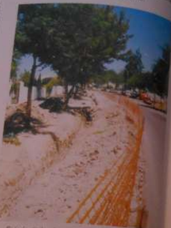
Estado de la obras en Avda. Manuel de Falla
