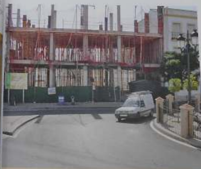
Continúan los trabajos en el edificio que albergará la nueva biblioteca.
