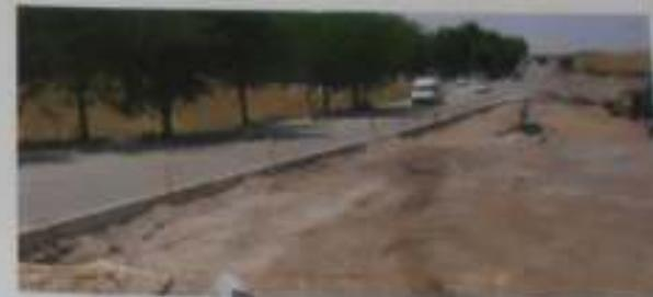
calle Calvario, y la calle Pico. Las obras consistirán en el levantamiento de la anterior calzada y en una nueva pavimentación de adoquines graníticos y losas de hormigón, además de un acerado a base de baldosas hidráulicas. Así mismo, se sustituirán las tuberías de saneamiento y el alcantarillado.
