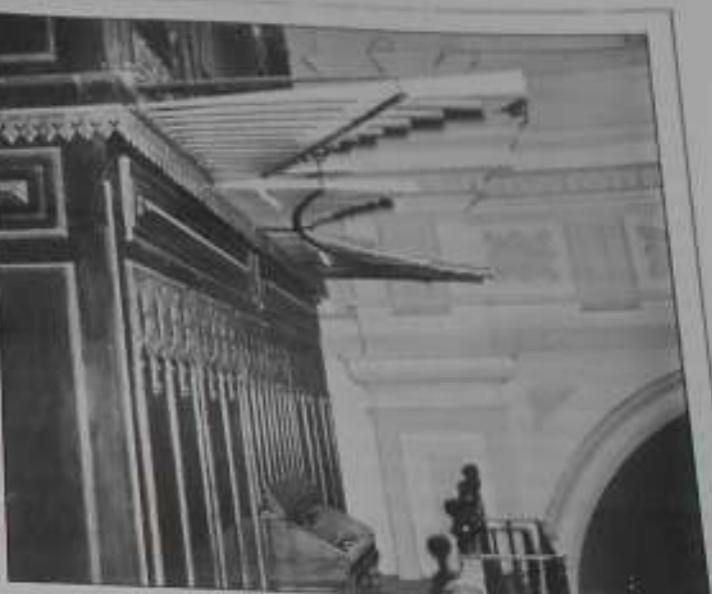
EL TUBULADO.- El órgano parroquial tiene un completo tubulado. Consiste de 132 tubos acústicos, todos metálicos. De ellos, 44 son cilíndricos y paralelos a la caja; en tanto que 88 son cónicos y perpendiculares a ella. El aire se hace vibrar en el interior del tubulado por medio de un fuelle y según la embocadura de cada tubo así es su sonido: de flauta, trompeta, corneta, clarín, violín, etc.
