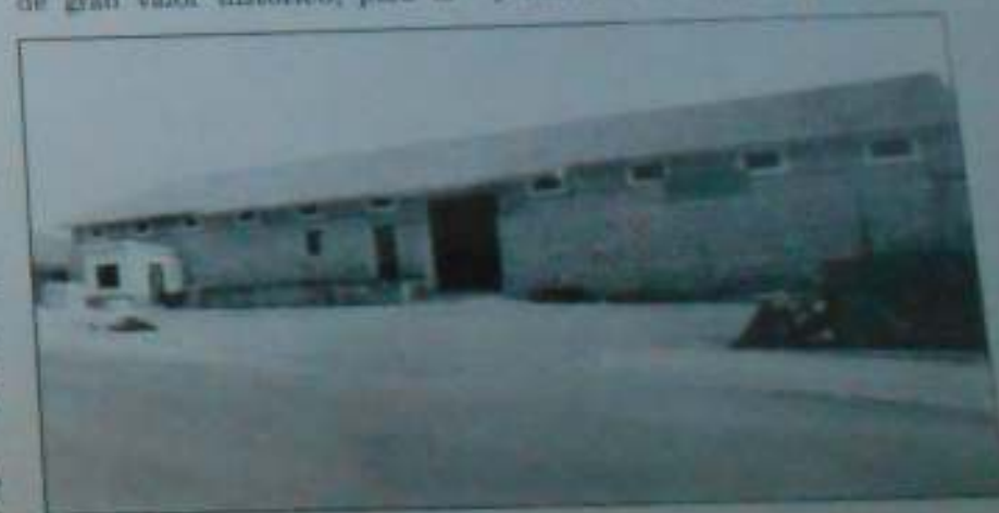
Edificio para la futura estación de autobuses
