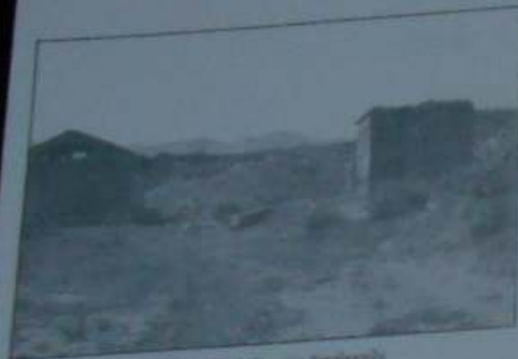
Estado actual de la Estación Navalagorda
