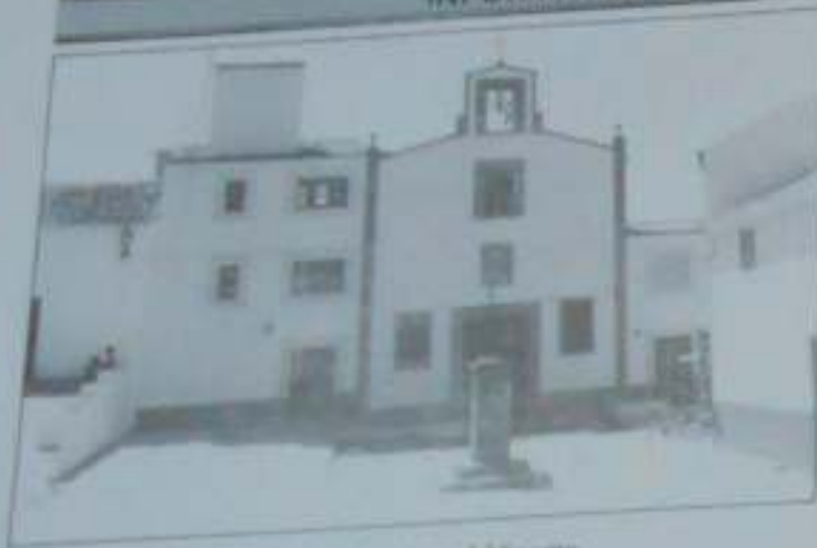
Residencia de ancianos del Socorro
