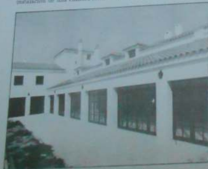
Edificio para el futuro hotel.
