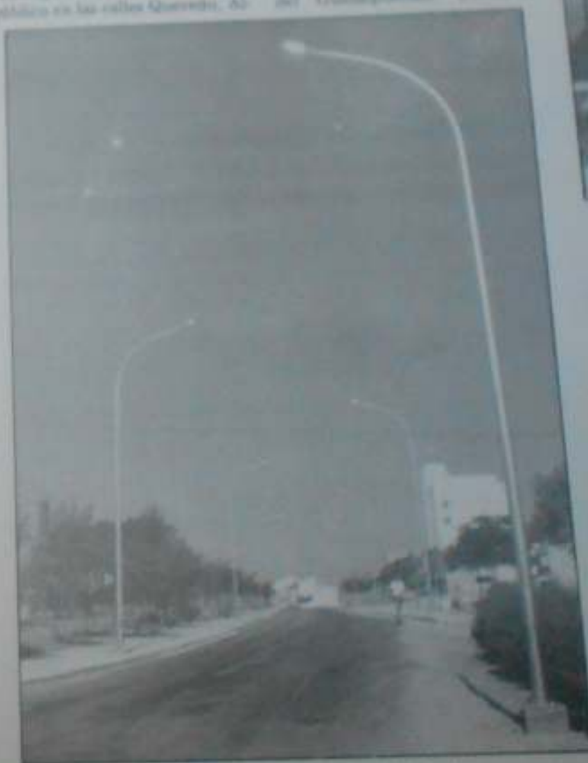
Nuevo alumbrado en avenida Julián Bectero
