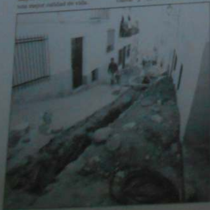
Trabajo del abastecimiento de agua.
