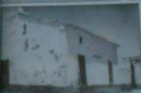
El viejo edificio del Mercado Municipal, para antes de ser destruido, en 1946, para construir en el mismo lugar el actual.
