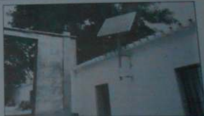
Energía fotovoltaica en vivienda rural
