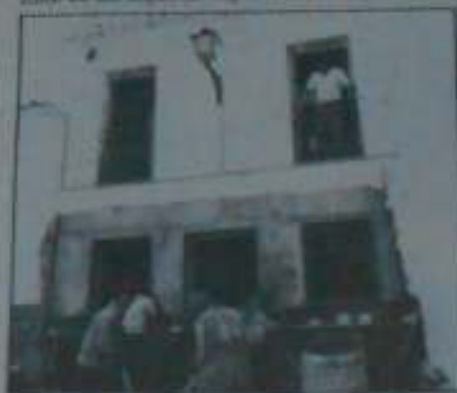
Casa construida por alumnos del curso de albañilería.
