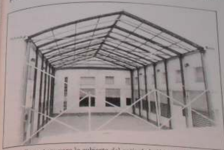
Estructura para la cubierta del patio de la Escuela Hogar
