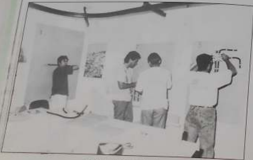
Módulo de Electricidad
