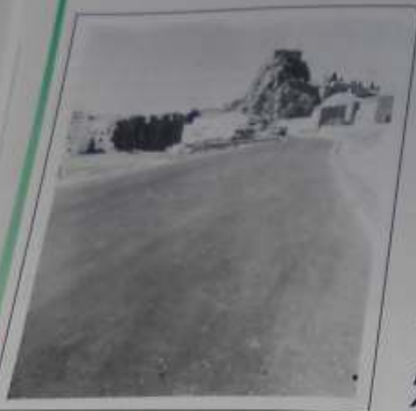
Mejora de la Carretera de acceso a la N-342
