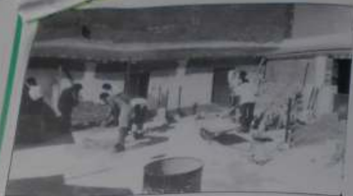
Módulo de Albañilería
