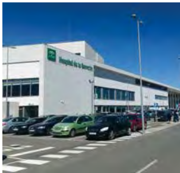
Una vista del nuevo Hospital de Ronda.
