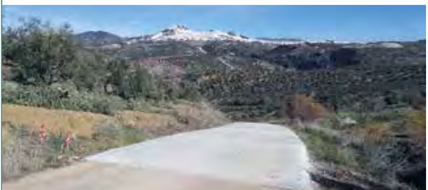
Arriba, arreglos en el carril de El Salado . Debajo, trabajos en el carril Eras Viejas .
